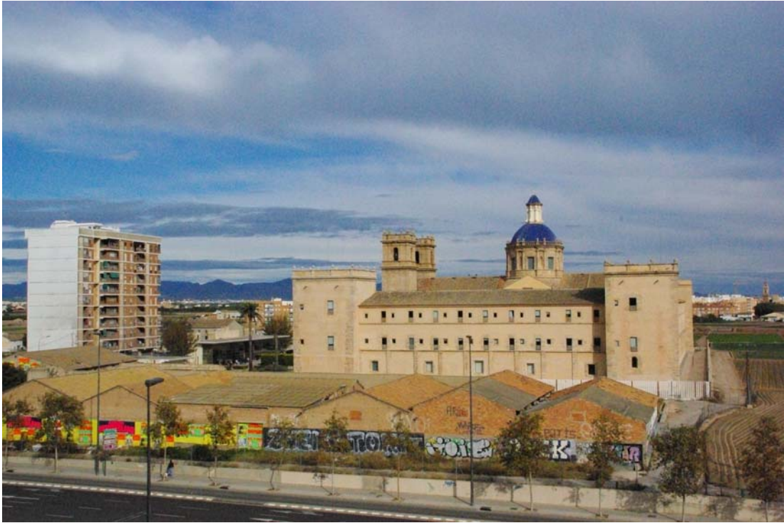
Derribo de naves y ampliación patio ajardinado del monasterio A la izquierda edificio de 10 alturas a derribar con realojo de vecinos
