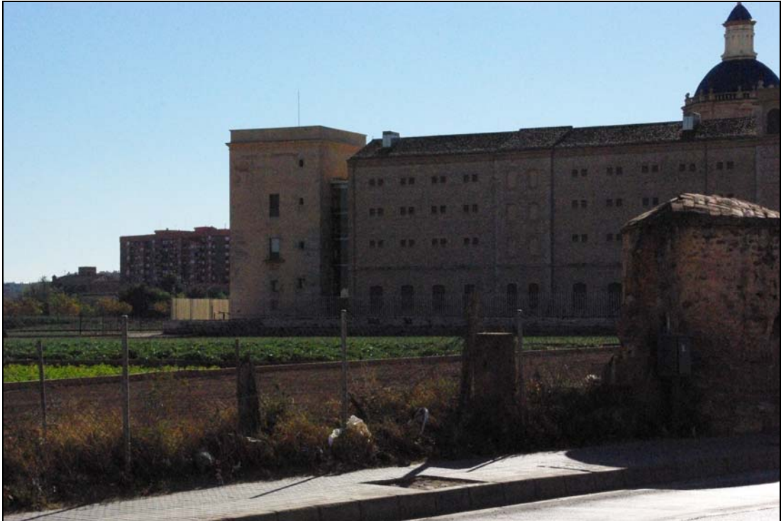
Reconstrucción muro perimetral de la huerta histórica
